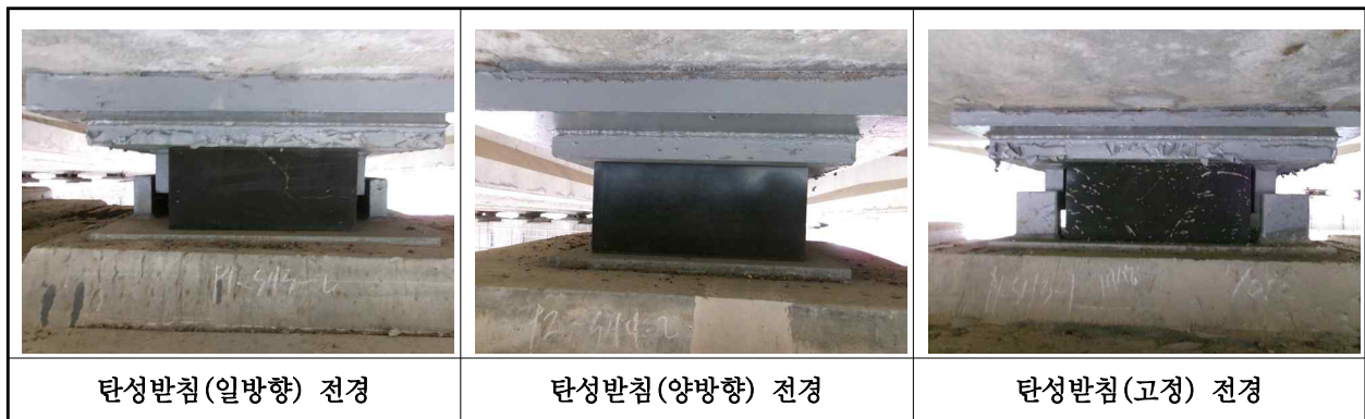
【사진 1.3.12】 교량받침 전경
