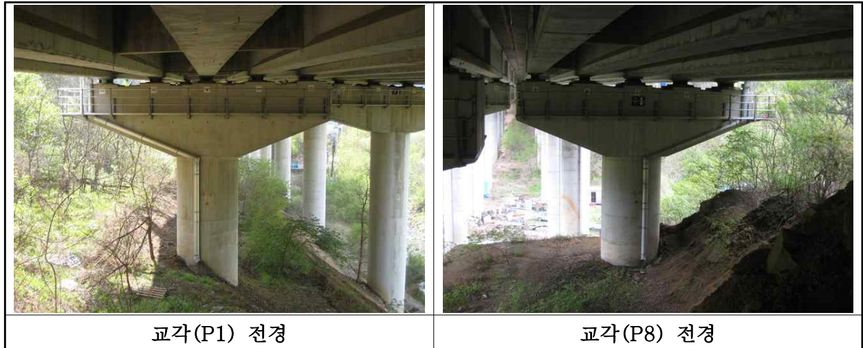
【사진 1.3.10】 교각 전경
