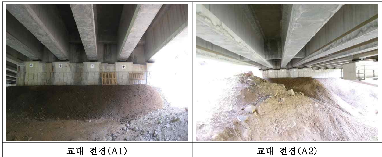
【사진 1.3.8】 교대 전경
