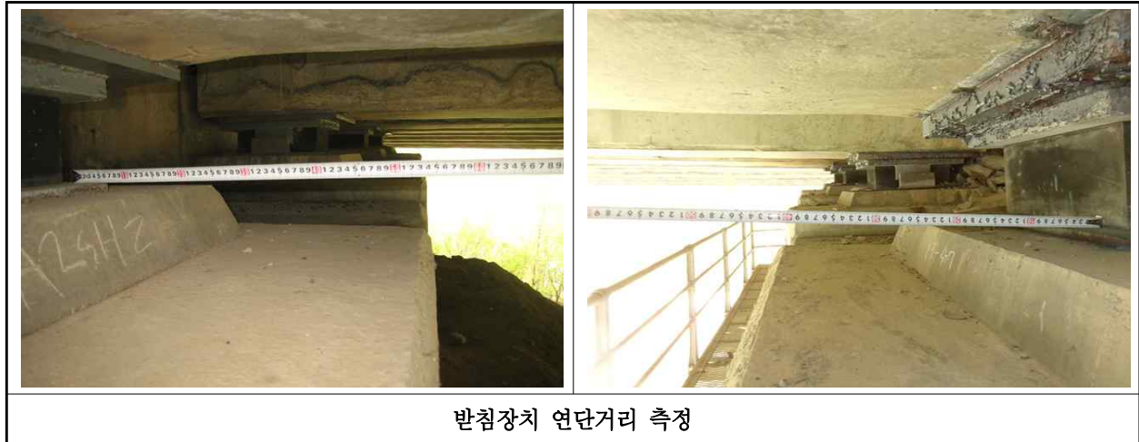
【사진 1.3.14】 교량받침장치 연단거리측정
