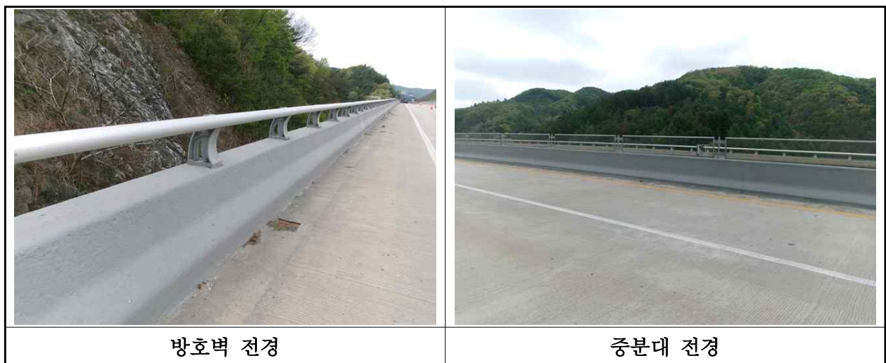
【사진 1.3.23】 방호벽 및 중앙분리대 전경
