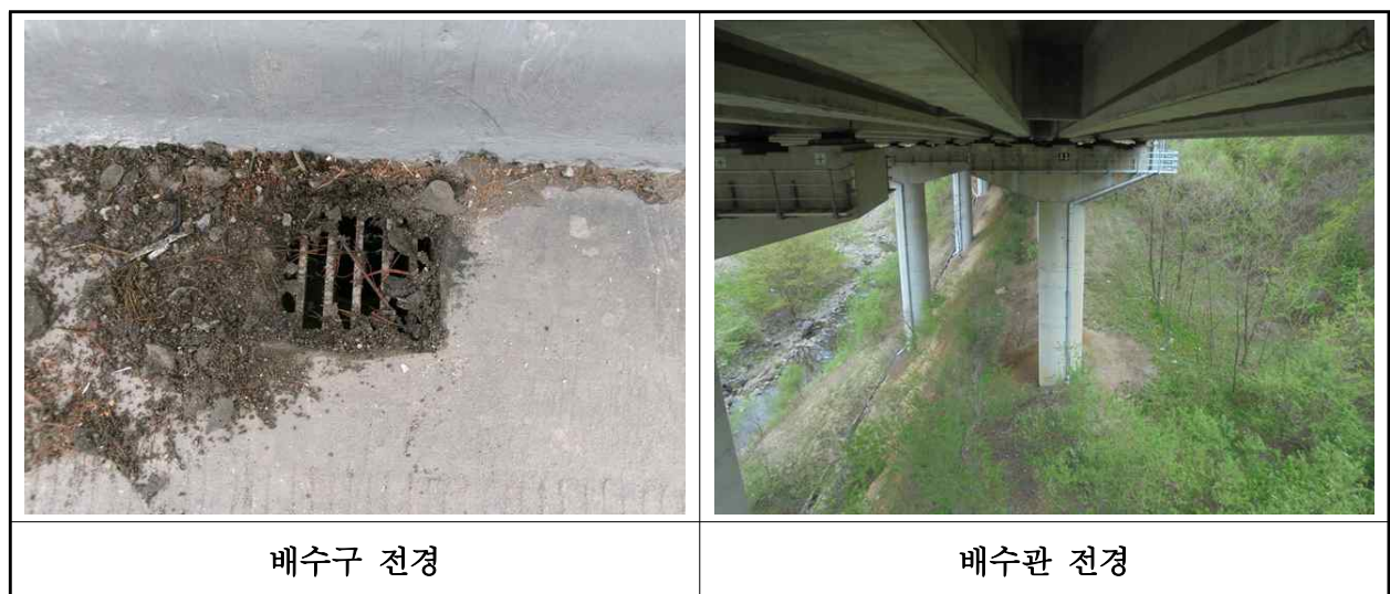
【사진 1.3.21】 배수시설 전경
