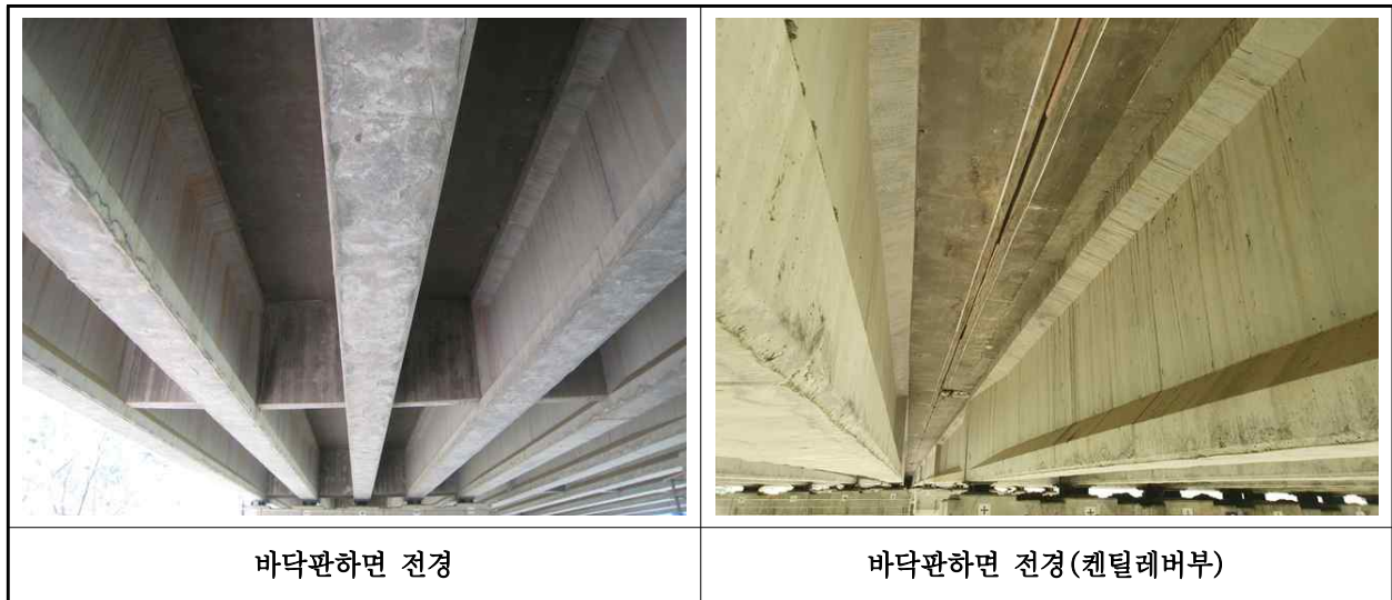
【사진 1.3.2】 바닥판하면 전경
