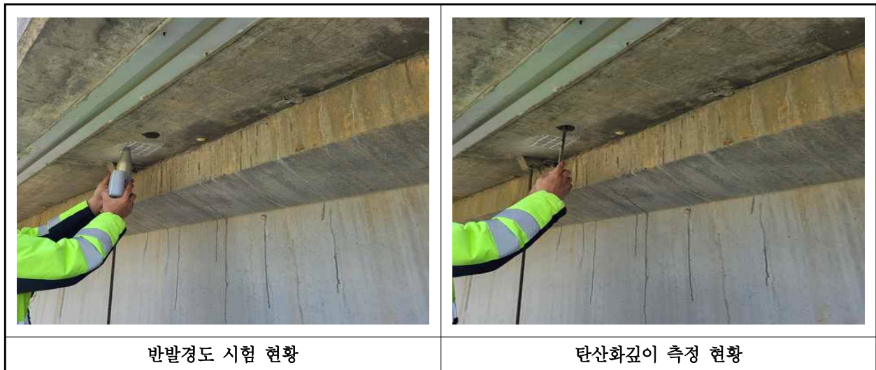
【사진 1.4.1】 콘크리트 내구성조사 현황
